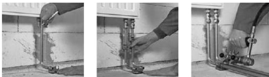
Для подсоединения Т и Г-образных трубок к радиаторным узлам Н типа мультифлекс рекомендуется применять обжимные соединения типа евроконус для медных труб 15x3/4".
